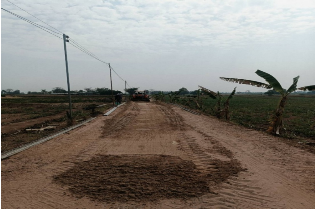
โครงการก่อสร้างถนนคอนกรีต บ้านโคกสูง หมู่ที่ ๘ งานปรับเกลี่ยแต่งทรายรองใต้ผิวคอนกรีตพร้อมติดตั้งแบบเหล็กหล่อคอนกรีต
