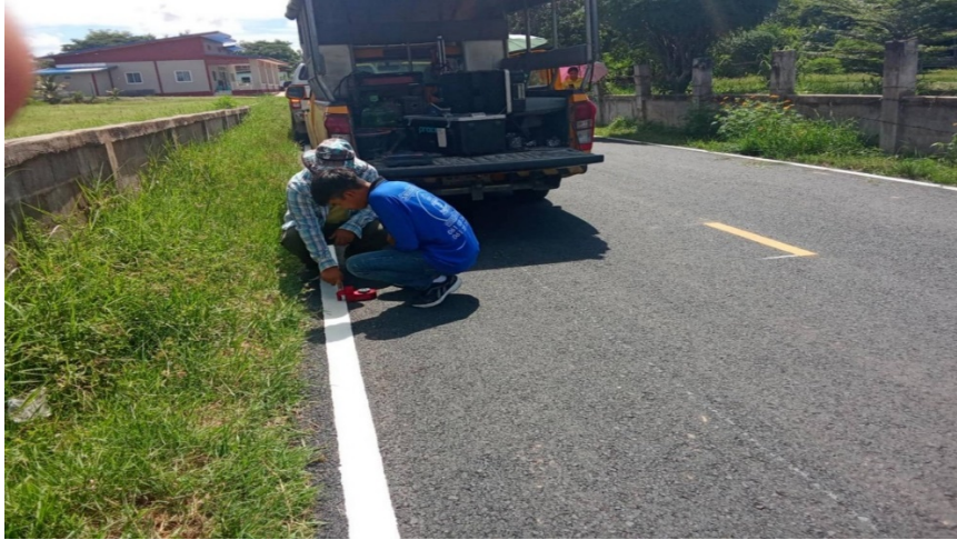
ภาพดำเนินการทดสอบงานตีเส้นจราจร
