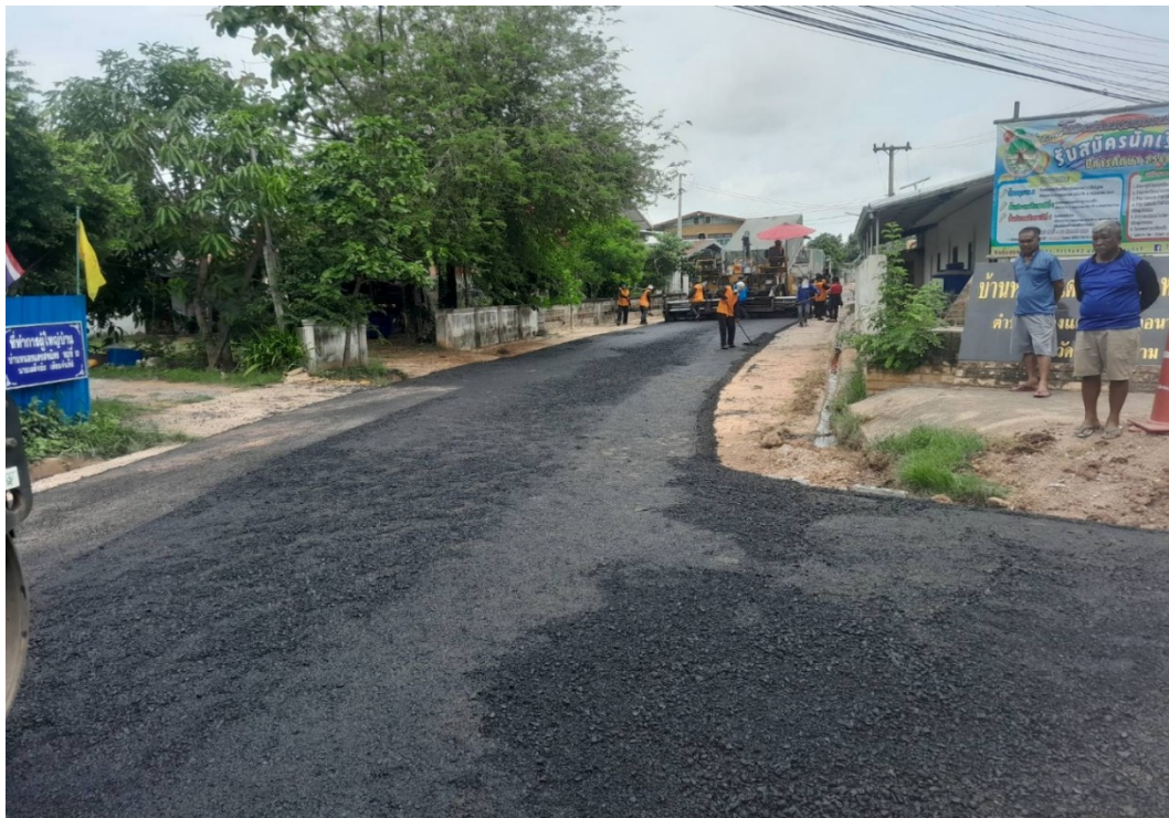
โครงการปรับปรุงถนนคอนกรีตโดยการเสริมผิวจราจรด้วยแอสฟัลท์ติกคอนกรีต บ้านหนองแดงสหมิตร หมู่ที่ ๑๐ จากถนนสายหลวงชนบท-โกสุมพิสัย-ไปสามแยกบ้านนายไพบูรณ์ สุทธิศาสตร์ ภาพขณะดำเนินการปูผิวจราจร
