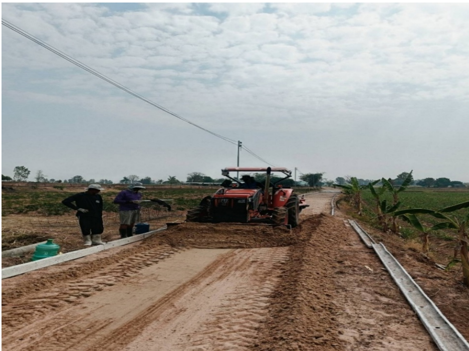
โครงการก่อสร้างถนนคอนกรีต บ้านโคกสูง หมู่ที่ ๘ งานปรับเกลี่ยแต่งทรายรองใต้ผิวคอนกรีตพร้อมติดตั้งแบบเหล็กหล่อคอนกรีต
