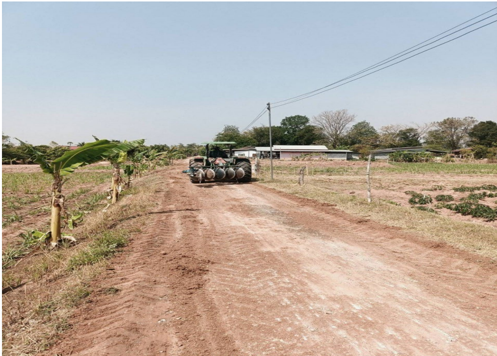
โครงการก่อสร้างถนนคอนกรีต บ้านโคกสูง หมู่ที่ ๘ งานปรับเกลี่ยแต่งพื้นทางเดิมและลงทรายใต้ผิวคอนกรีตพร้อมติดตั้งแบบเหล็กหล่อคอนกรีต
